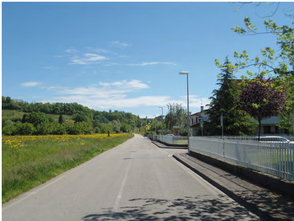
Via del Torrione Philips Selenium (ottica full cut-off)
