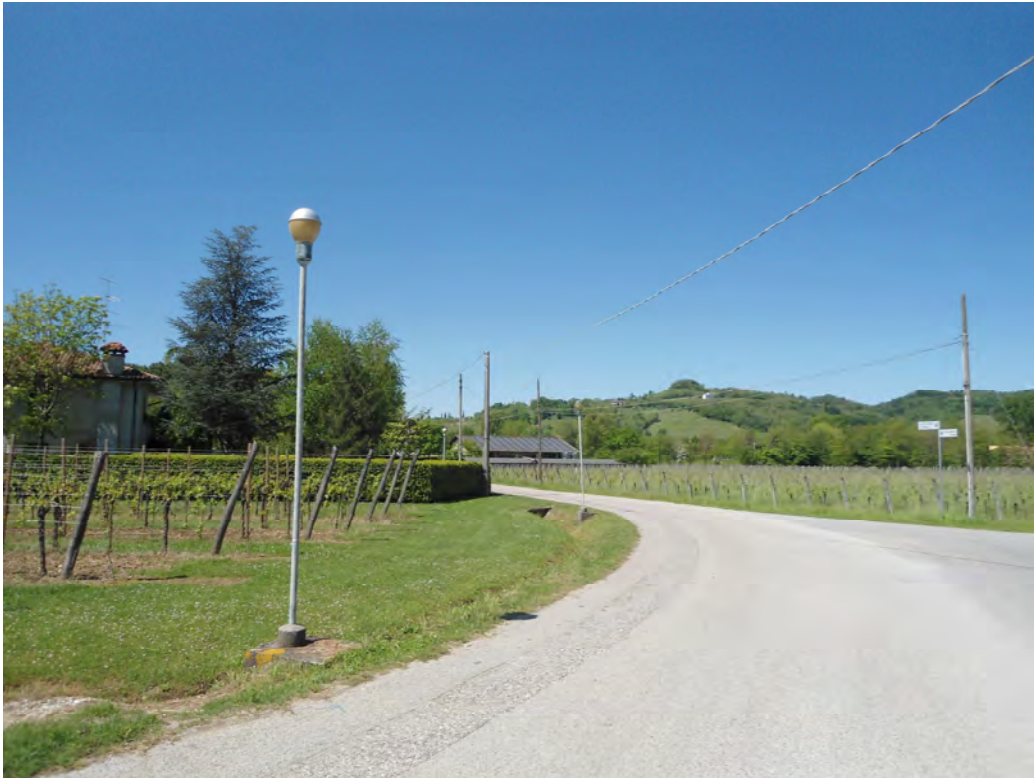
Via Pra di Cort lampioncini (ottica non cut-off da sostituire)
